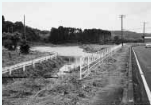
関東大震災のとき県道に水がこぼれた女ヶ堰
